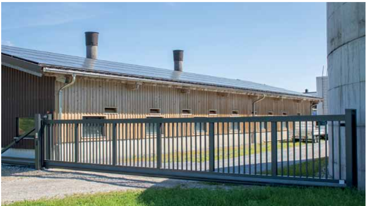
Schiebetor mit elektrischem Antrieb
